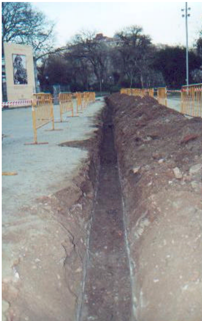
Foto.14: Detalle de la rasa 9000 un cop excavada.
