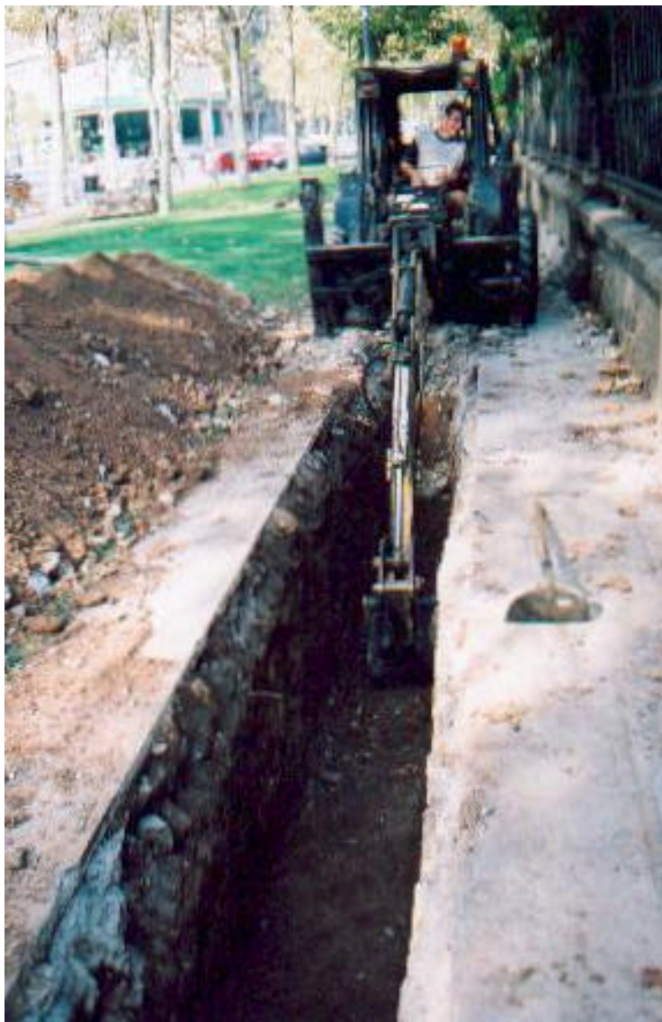
Foto.5: Detall de l'excavació de la rasa 2000.
