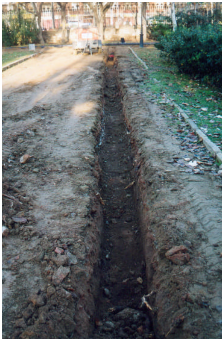
Foto.13: Detall de la rasa 9000.
