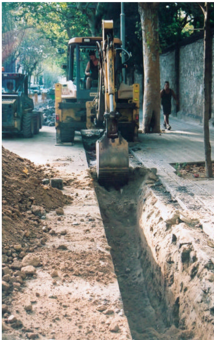
Foto. 1: Detall de l'excavació de la rasa 1000.
