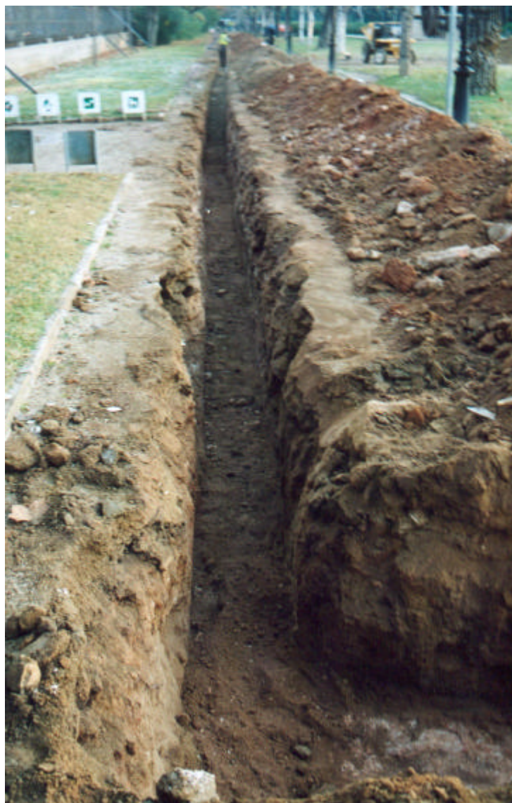
Foto.8: Rasa 5000 un cop excavada.
