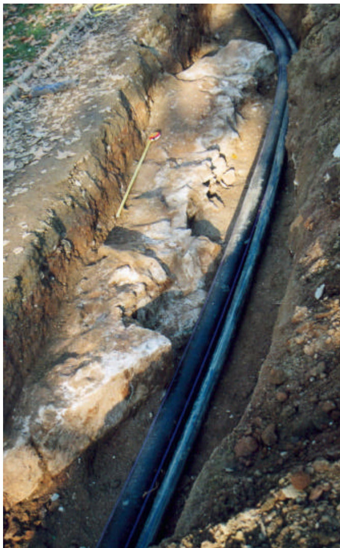
Foto.10: Detall del mur UE 5008 amb els tubs ja posats.
