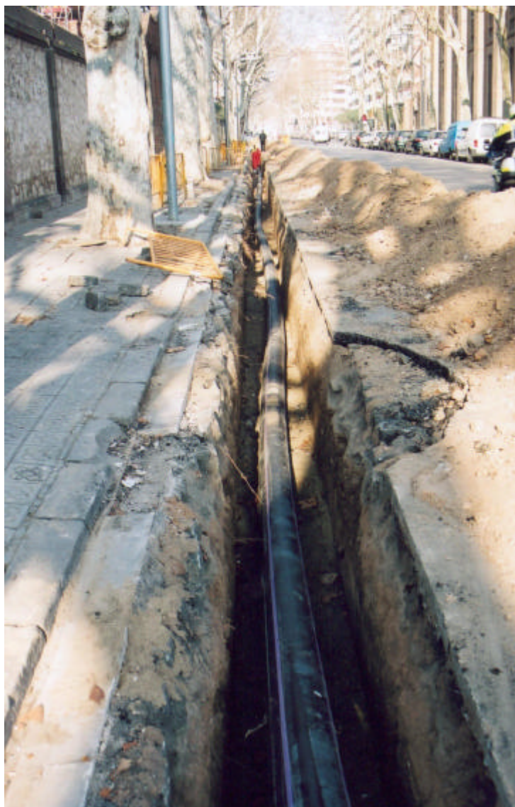
Foto. 3 : Detall de la rasa 1000 un cop excavada i amb els tubs ja col.locats.
