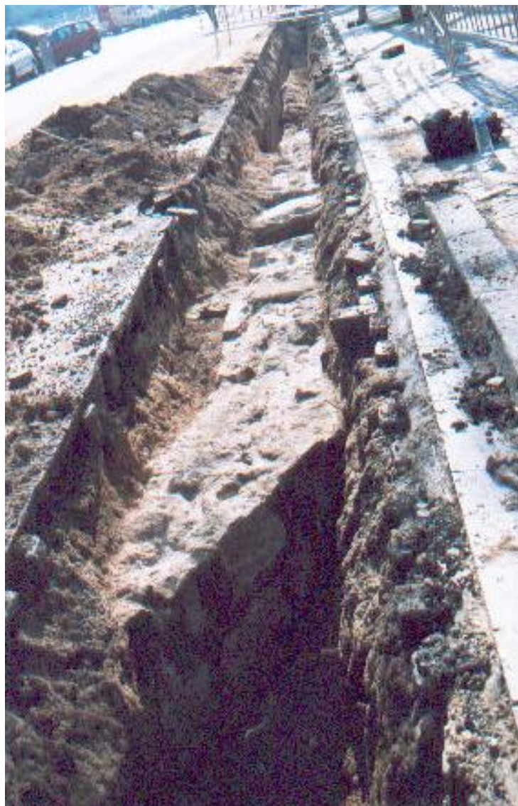
Foto.2 : Detall dels murs UE 1013 i UE 1014.
